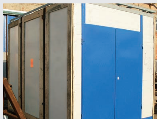
Готовый модуль перед отгрузкой зашивается специальными щитами
