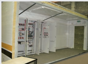
ЗРУ 6 кВ с 2КТПП-1000/6/0,4 в модульном здании
