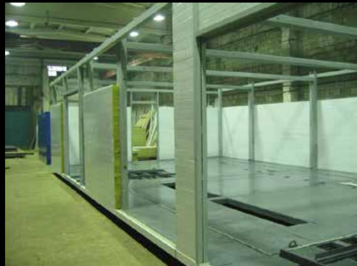
Силовой каркас здания имеет термическую защиту 90 минут что, обеспечивают II степень огнестойкости модульного здания.
