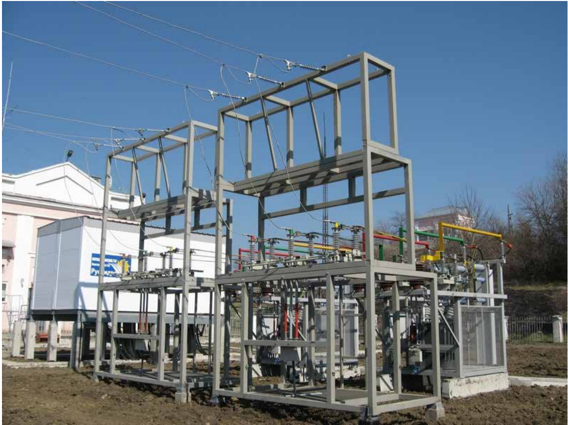
Рисунок 8 – Приемные порталы с разъединителями
