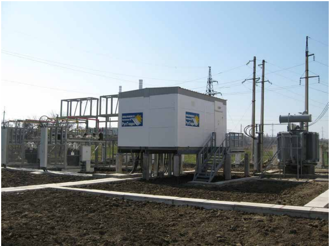
Рисунок 10 – Модульное здание с ячейками NXPLUS-35 SIEMENS
