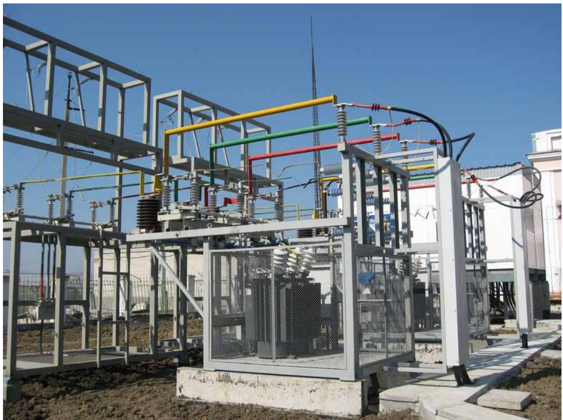
Рисунок 9 – Блок ТСН с трансформаторами тока
