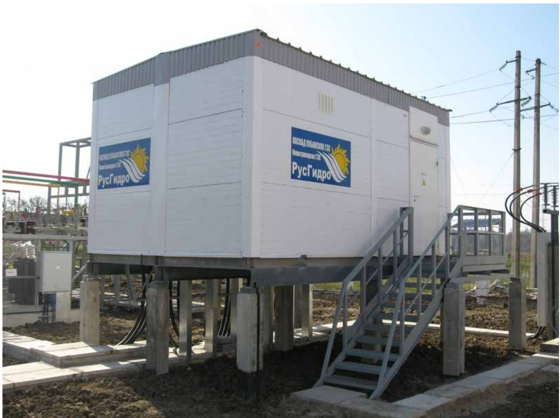
Рисунок 11 – Модульное здание с ячейками NXPLUS-35 SIEMENS
